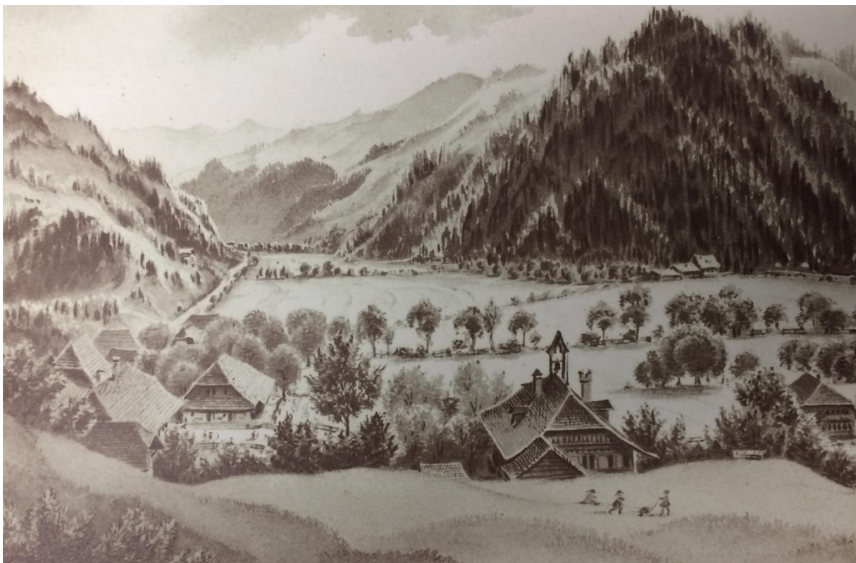
Helfereigebäude Trubschachen um 1850. Noch fehlen das Dorfschulhaus und die Bahnlinie. Rechts aussen das Himmelhaus.
